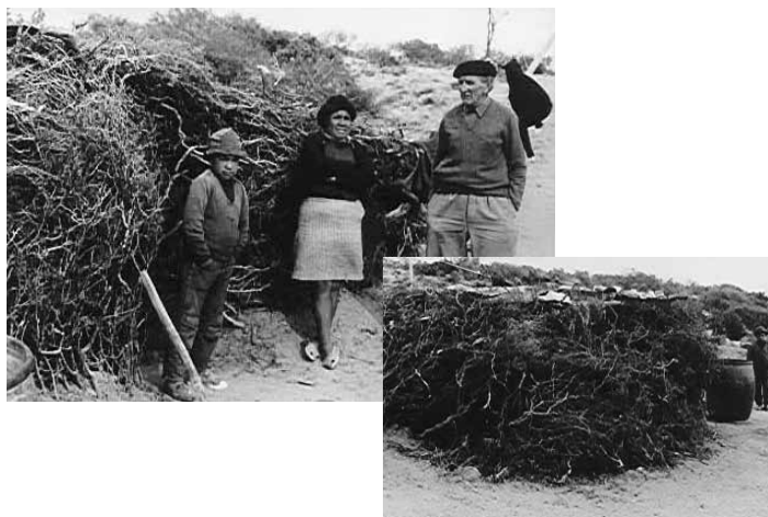
■ Imagen 2/ Viviendas de pescadores artesanales en la zona en estudio hacia 1970. Es importante señalar el uso de especies del matorral patagónico para conformar verdaderos “iglúes” del semi- desierto. Este tipo de construcción se utilizaba también para conservar la captura de pulpo, durante un par de días, hasta tanto arribaba el vehículo que transportaba la carga a la zona de venta. Fuente: Fotografía tomada por el Dr. Orensanz, usada con su autorización.
